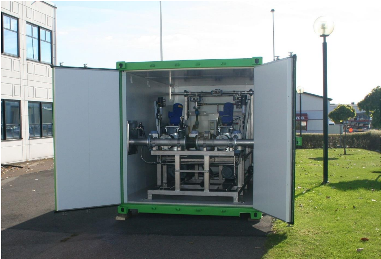
Container med BioCept installerad före transport till Swedish Biogas biogasanläggning i Jordberga utanför Malmö.
