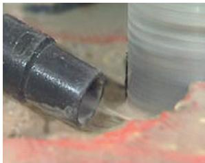
Uppsamling av slam under borring. Bilden visar vätsugens munstucke samt betongborret i aktion.
