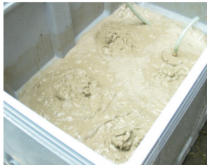
Uppsamlingscontainer. Här tömms borrslammet efter uppsugningen.
