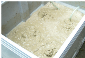
Uppsamlingscontainer. Här tömms borrhslammet efter uppsugningen.
