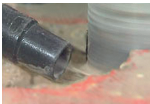
Uppsamling av slam under borrhning. Bilden visar vattsugens munstucke samt betongborret i aktion.
