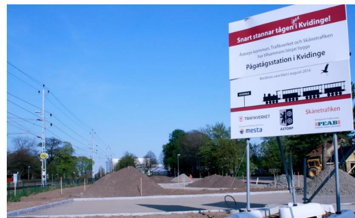
Figur 7, bild på byggarbetsplatsen för den nya tågstationen i Kvidinge. Fotograf: Alexandra Berg von Post
